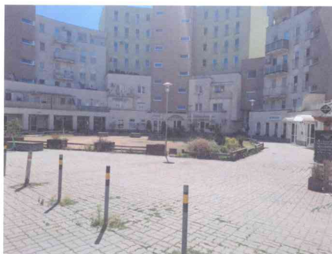
Vnútroblok bytového domu
