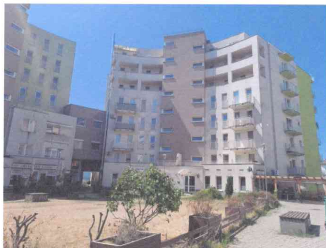
Pohľad na bytový dom zo severnej stran
