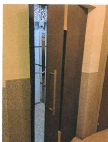
Spoločné priestory bytového domu
